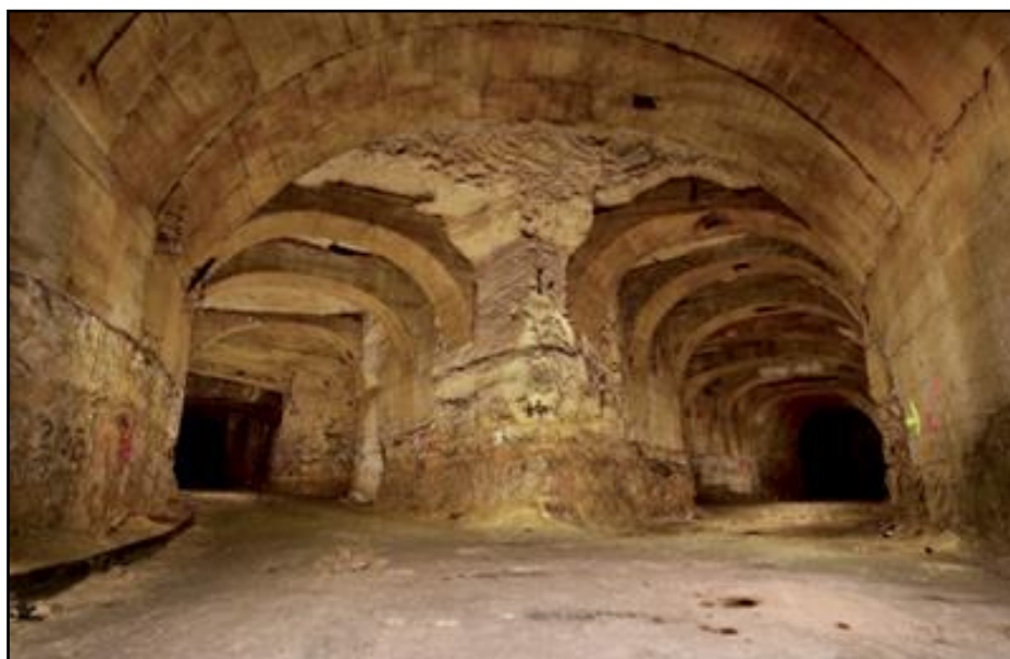
Autre belle photo montrant un carrefour des galeries annexes desservant les quais de déchargement de la gare souterraine
