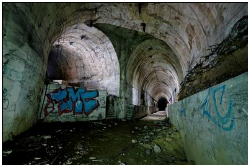
Quai de déchargement n° 1
