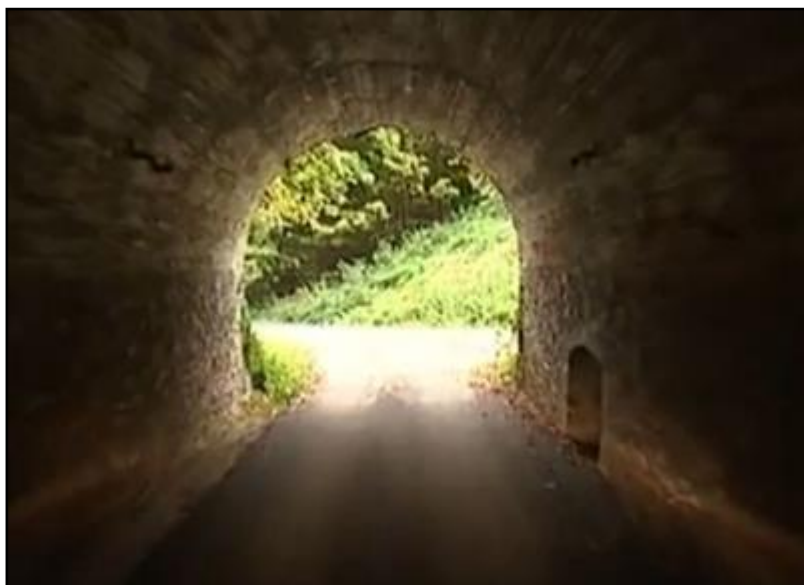
La sortie vue de l'intérieur
