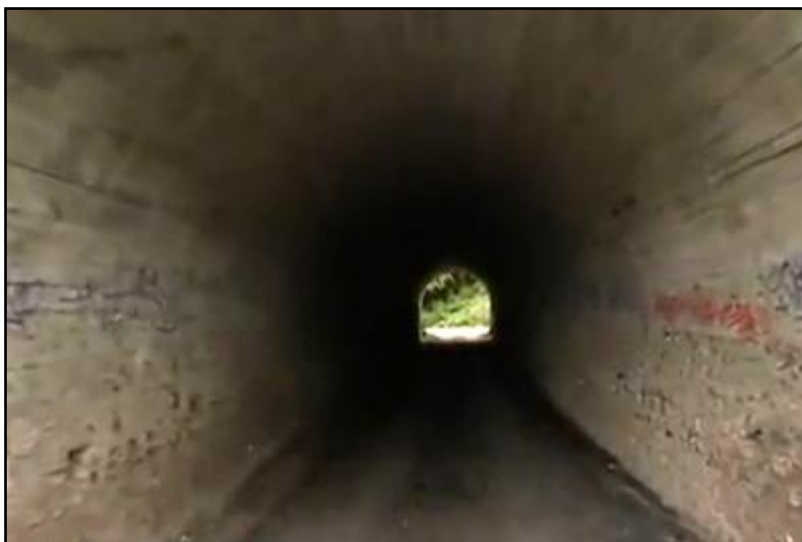
La galerie bétonnée du tunnel
