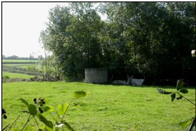
L'ouverture discrète de la cheminée centrale d'aération de 86 m de profondeur et son débouché dans l'un des pénétrons du tunnel
