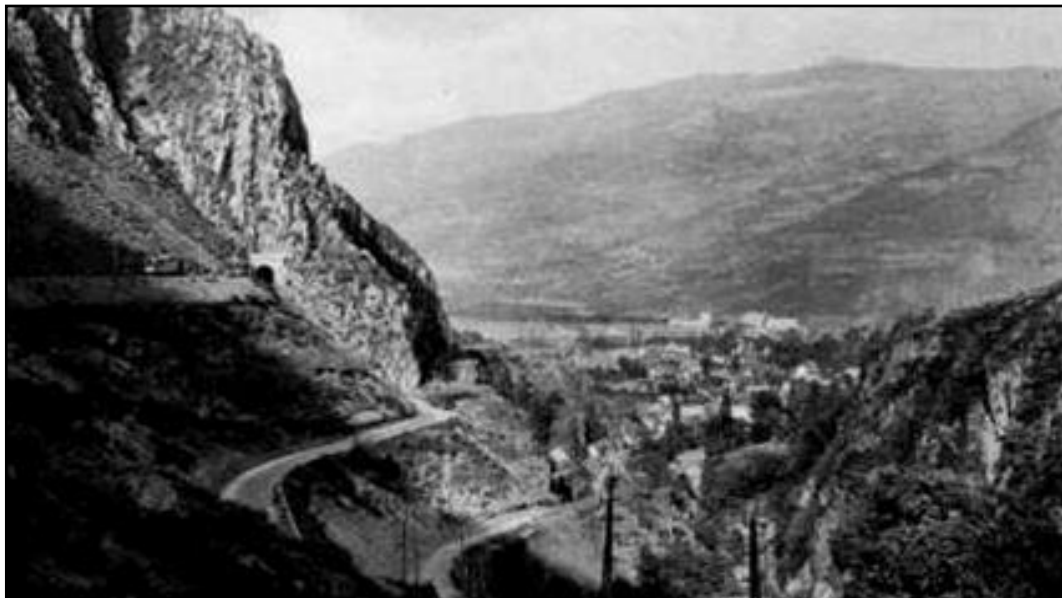
La sortie du tunnel dans la falaise de Cap d'Estang avec, au fond, Pierrefitte Nestalas
