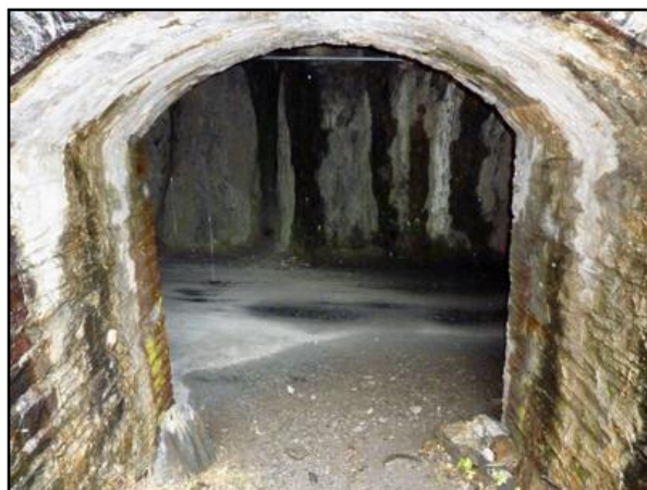
La fenêtre vue depuis l'extérieur
