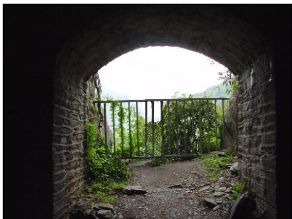
Ci-dessus et ci-dessous, l'ouverture de la fenêtre tunnelière
