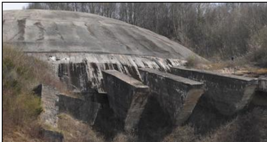
Détail du dôme blindé et de ses contreforts de maintien
