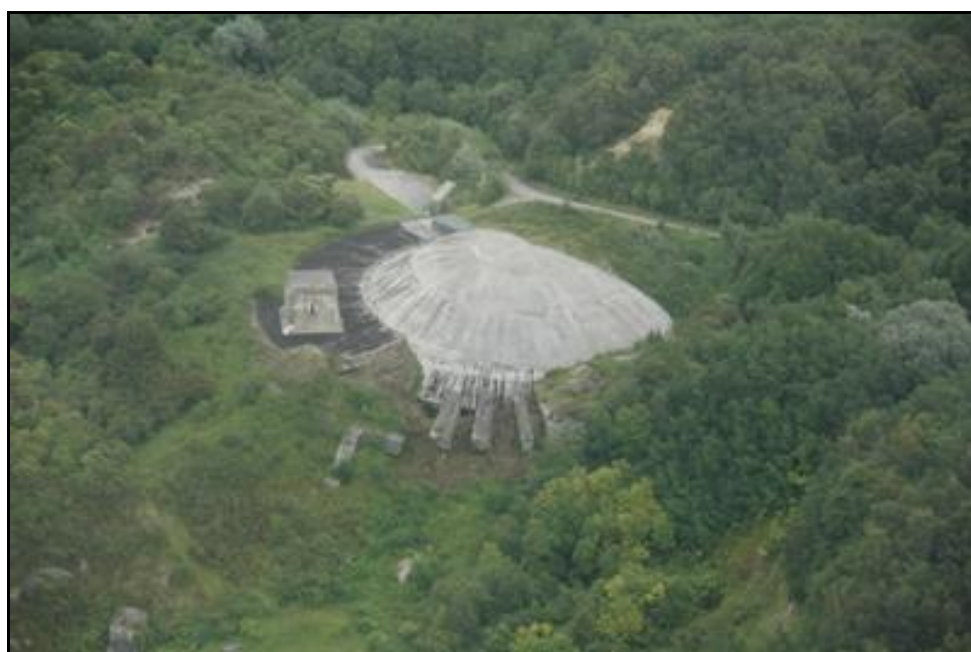
Vue aérienne du dôme blindé géant du hall de montage
