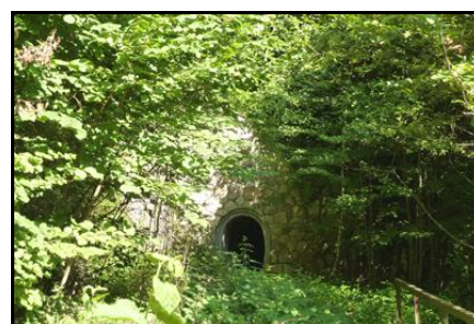
La sortie bouchée avec son drain type égout
