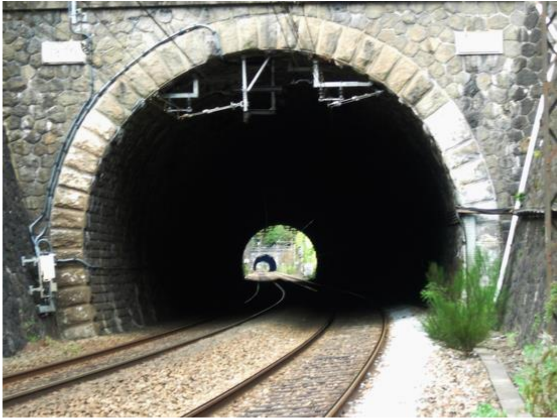
Au fond, le tunnel du Briard (Juillet 2017)
