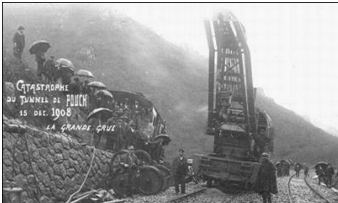
La grue de secours
