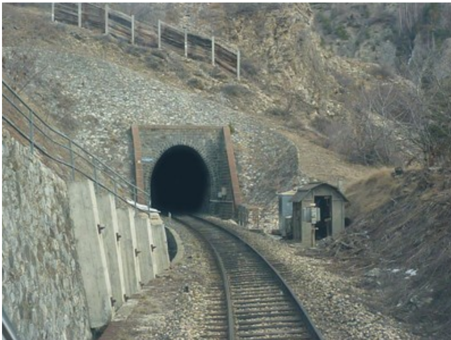
L'entrée du tunnel, avec des renforcements du mur de soutènement visibles à gauche.
