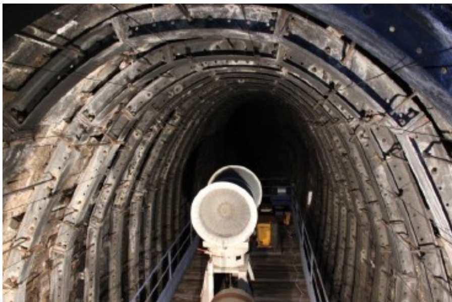
Zone confortée par des cintres
